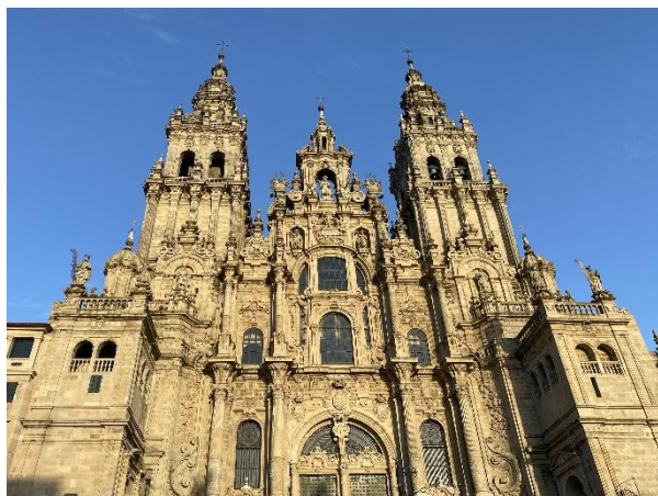
34 – Fernando de Casas y Novoa – “Fachada do Obradoiro” em Catedral de Santiago , 1738-1750. Santiago de Compostela, Espanha.
